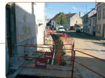
Enfouissement des réseaux EDF, France telecom, éclairage public et renforcement du réseau d'eau potable rue Milon
